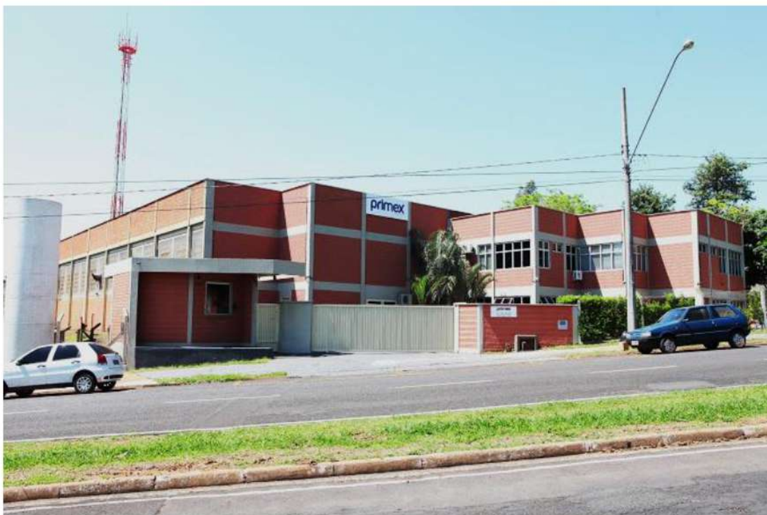
Fachada externa Primex (Vista da rua)
