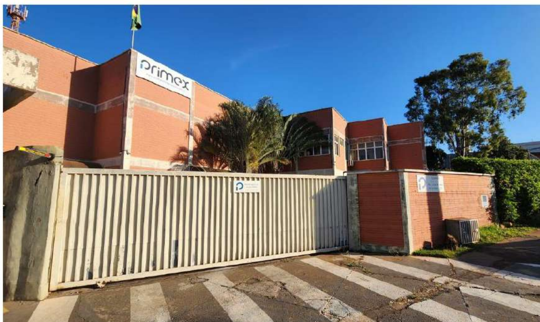
Fachada externa Primex (Vista da calçada)
