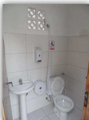
Vista interna do banheiro destinado para caminhoneiros terceirizados que prestam serviço para a Empresa Dermiwil
