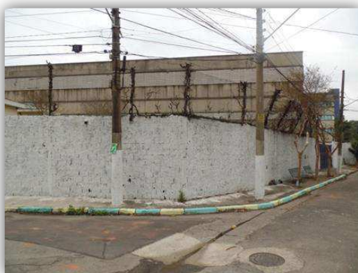
Vista parcial da fachada do imóvel avaliando (Rua Dr Romeu Bertelli esquina com o antigo trecho da Rua Marcos Arruda, que atualmente se tornou uma "praça" fechada)
