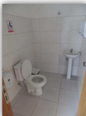
Detalhe do banheiro masculino
