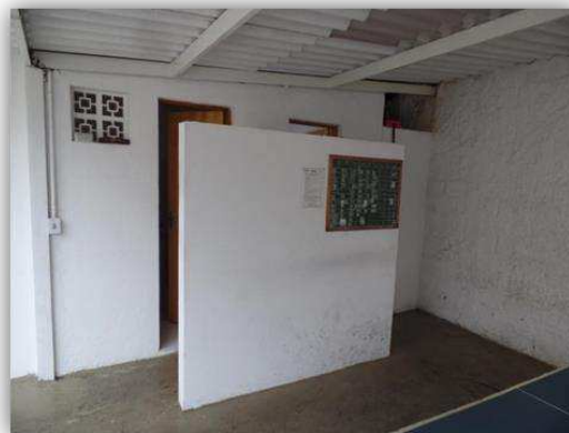
Vista externa dos banheiros masculino e feminino da área de convivência e lazer para funcionários da Empresa Dermiwil
