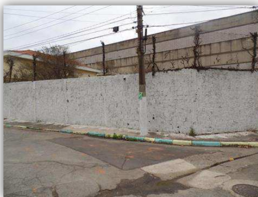
Vista parcial da fachada do imóvel avaliando (Rua Dr Romeu Bertelli)
