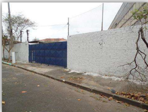
Vista parcial da fachada do imóvel avaliando (antigo trecho da Rua Marcos Arruda que se tornou uma “praça” fechada, cujo acesso é realizado a partir da Rua Dr Romeu Bertelli)
