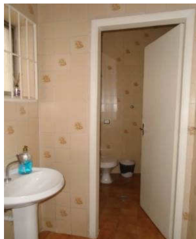
BANHEIRO 2º PAVIMENTO
