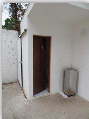
Vista externa do banheiro destinado para caminhoneiros terceirizados que prestam serviço para a Empresa Dermiwil
