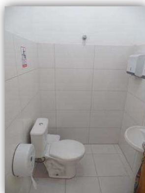
Detalhe do banheiro feminino
